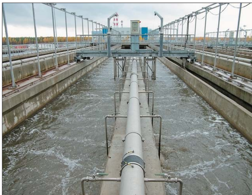
Рис.1. Отстойники очистных сооружений химических предприятий — естественная среда обитания микроорганизмов-деструкторов.
